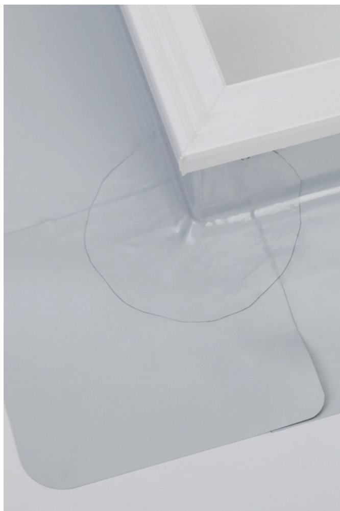
Costière alwitra avec manchette de raccordement
