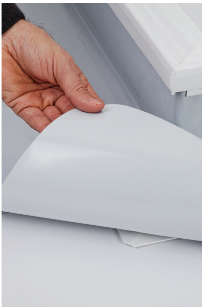
Costière alwitra avec manchette de raccordement : détail d'un coin
